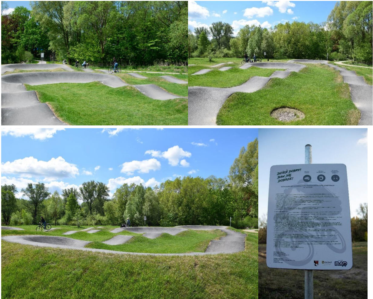
Rys. 4.1. „Budowa rowerowego placu zabawy typu pumptrack”.
