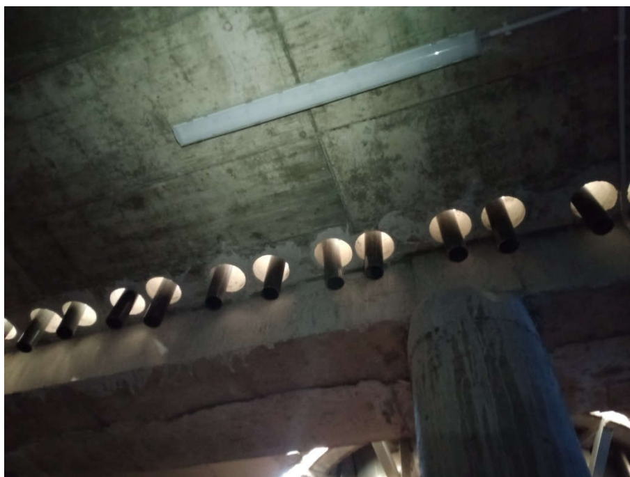
FOT. 14 Widok na wycięcia w płycie podbasenia przy osi F
