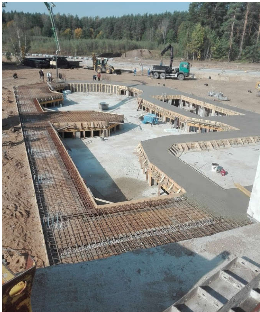
FOT. 7 Zdjęcie archiwalne – przedstawiające betonowanie stropu podbasenia z obsypanymi ścianami zewnętrznymi
