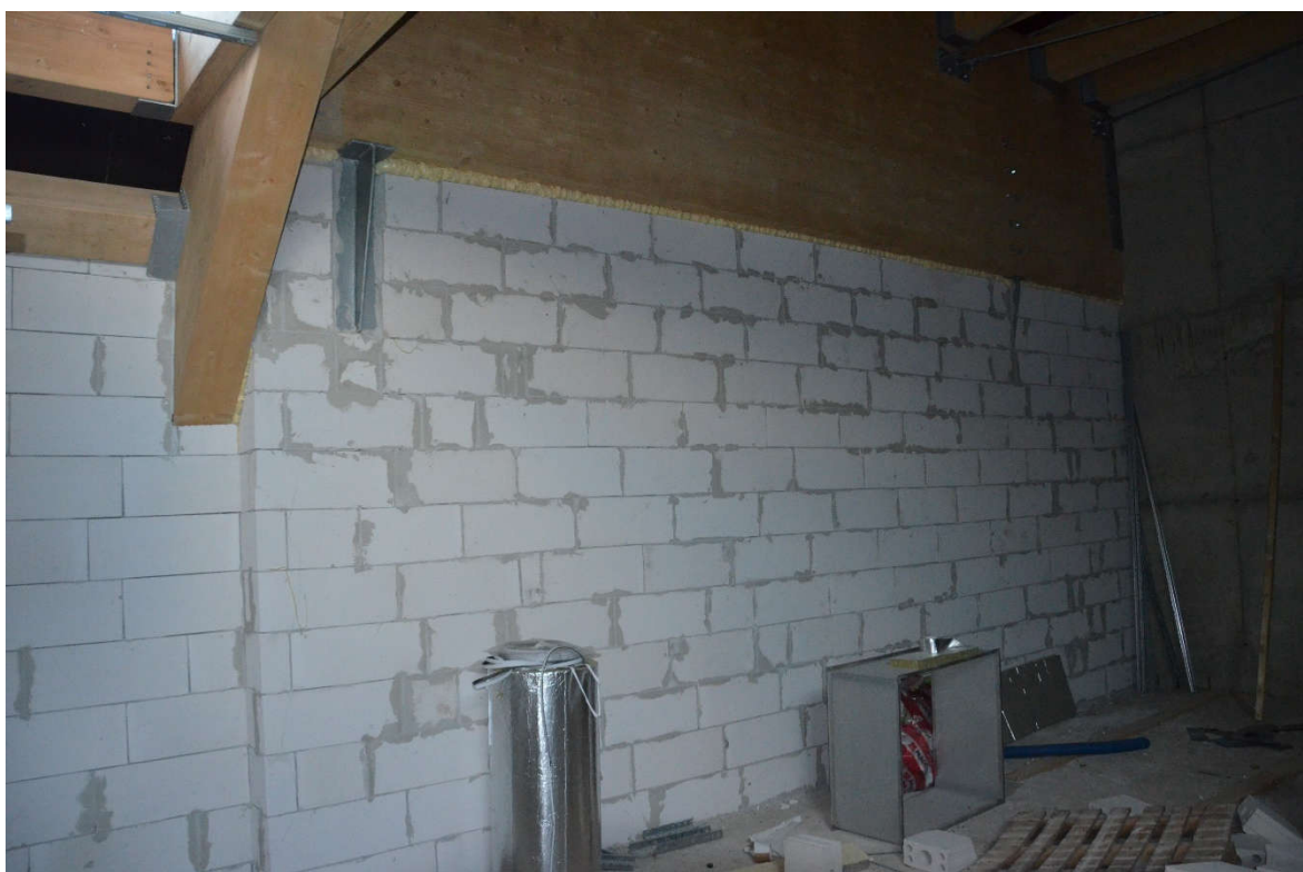
Fot. 27 podmurowany dźwigar w osi G, widoczny rygiel ramy z osi 12
