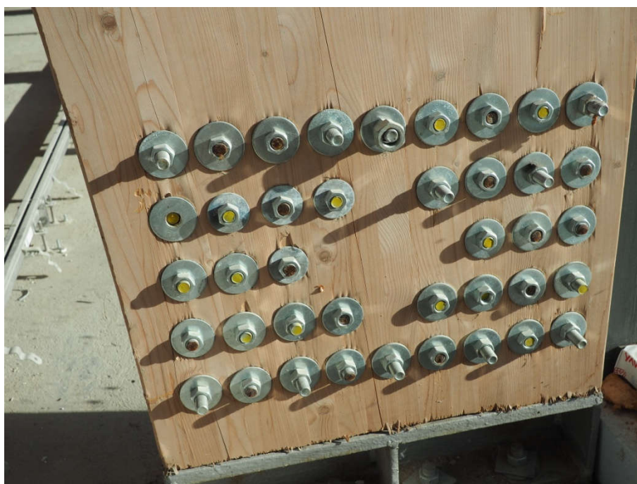
FOT. 24 Niepoprawne połączenie ramy w postaci obciętych sztang z gwintem
