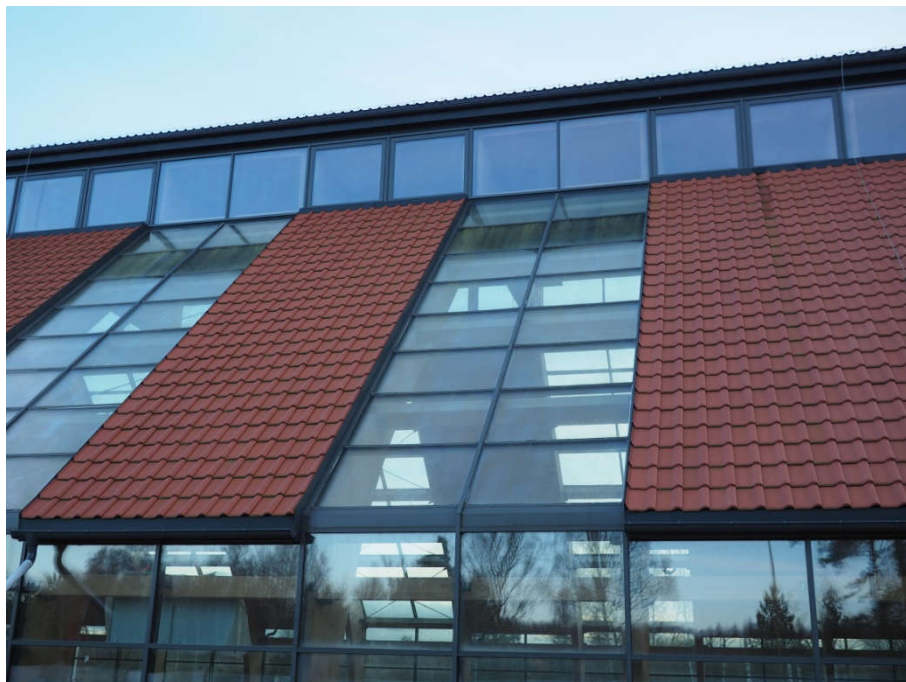
FOT. 33 Widok dachówki bez odpowiednich elementów zakańczających na połaci północnej
