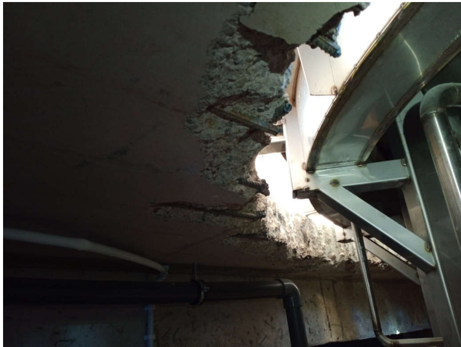
FOT. 10 Widok wycięcia stropu pod jacuzzi – widoczna zbyt mała otulina
