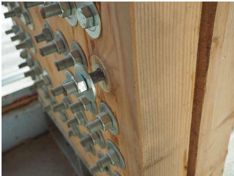
FOT. 25 Widok części gwintowanej sztangy w drewnie
