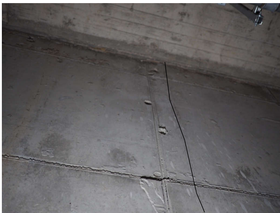
FOT. 6 Widok na zarysowanie na ścianie podbasenia w osi B
