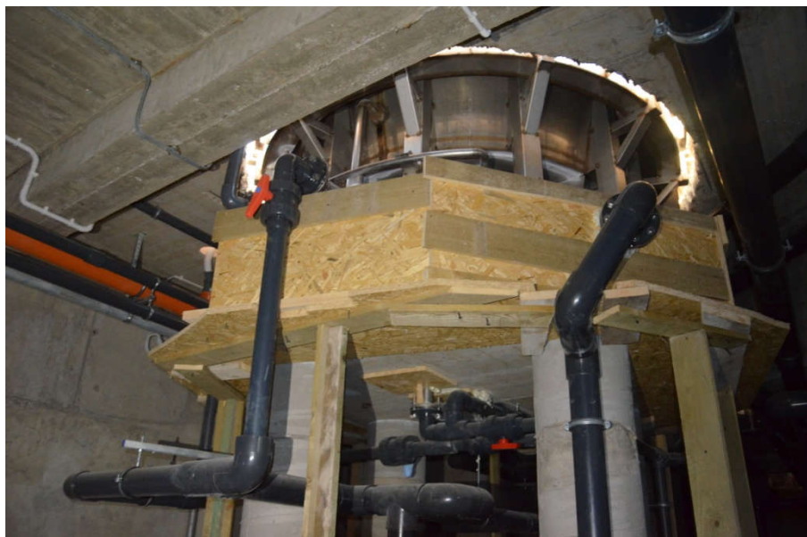
FOT. 18 Widok na strop jacuzzi oparty na czterech słupach okrągłych
