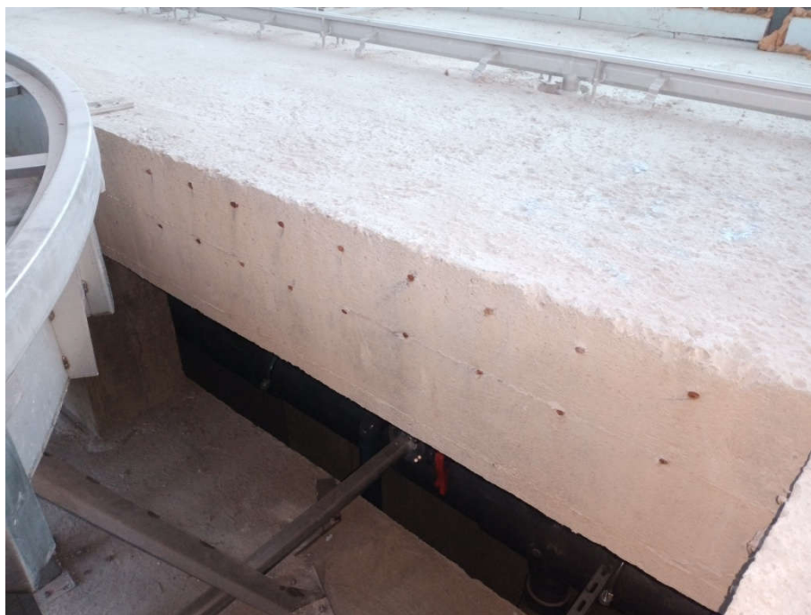
FOT. 15 Widoczne miejsce do dobetonowania – przy okazji widać zastosowane zbrojenie i zbyt dużą otulinę górną płyty
