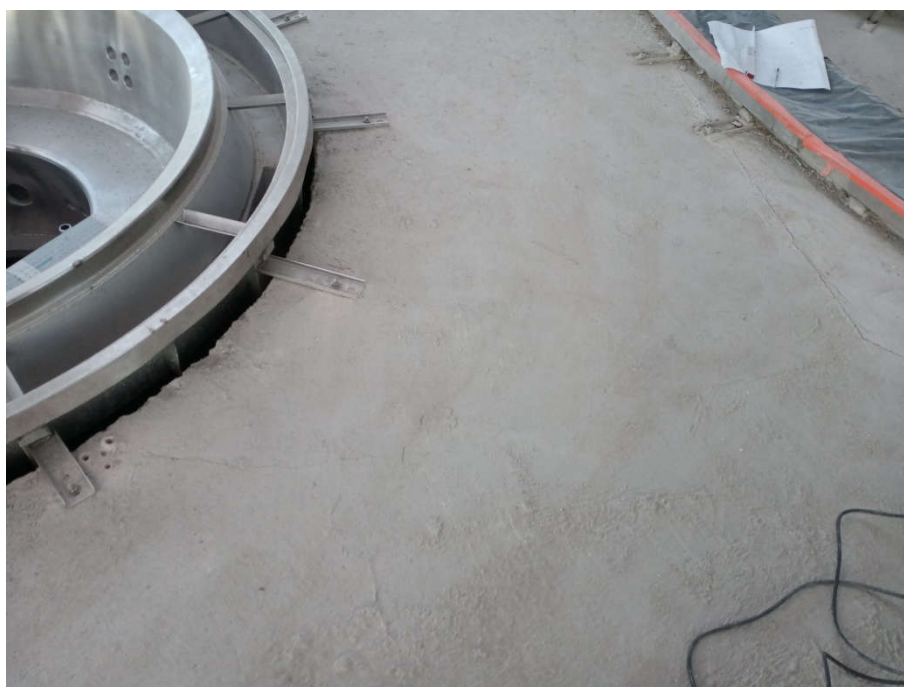
FOT. 12 Pęknięcie płyty podbasenia, widoczny nieudolny sposób dobetonowania stropu
