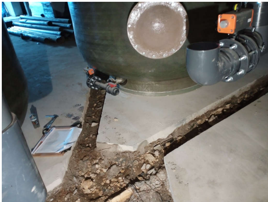
FOT. 3 Widok rozkuć pod instalacje kanalizacji przysypane piaskiem z budowy, oraz zbiorniki stojące na posadzce
