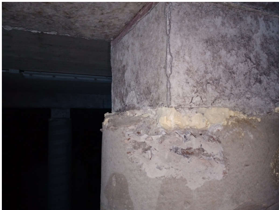
FOT. 17 Odkrywka otuliny słupa żelbetowego
