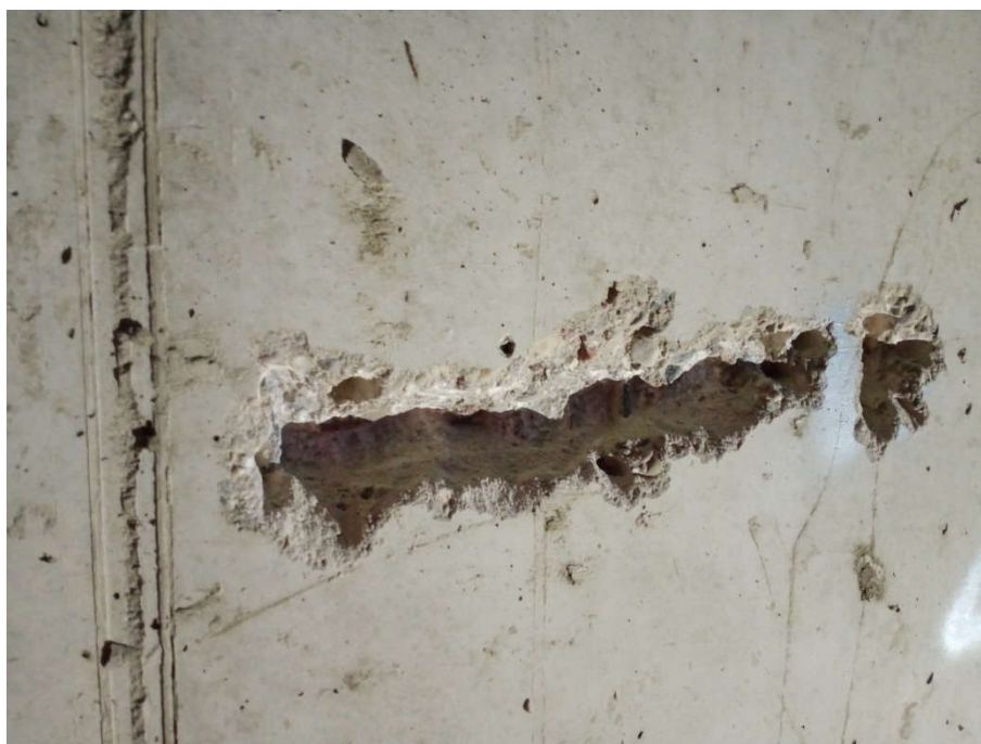
FOT. 4 Odkrywka ściany zewnętrznej widoczne zbrojenie pionowe #10 co 20cm, otulina 30mm
