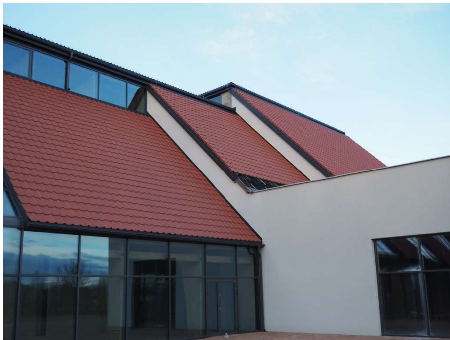
FOT. 19 Widok fragmentu niedokończonego dachu który doprowadził do zalania płyty stropodachowej.
