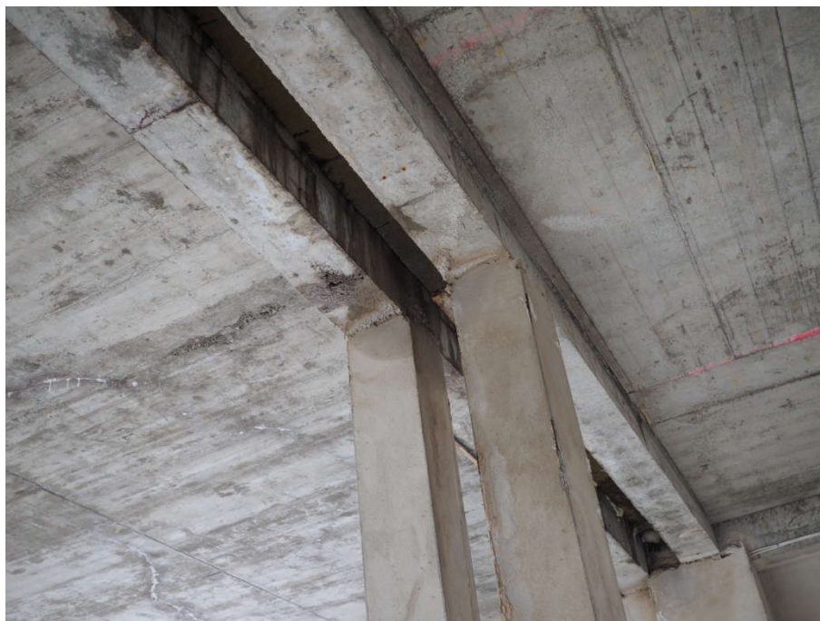
FOT. 20 Widoczne zalanie dylatacji spowodowane niedokończonym dachem, cały stropodach jest zalany, więc całe przykrycie razem z izolacją kwalifikuje się do wymiany.
