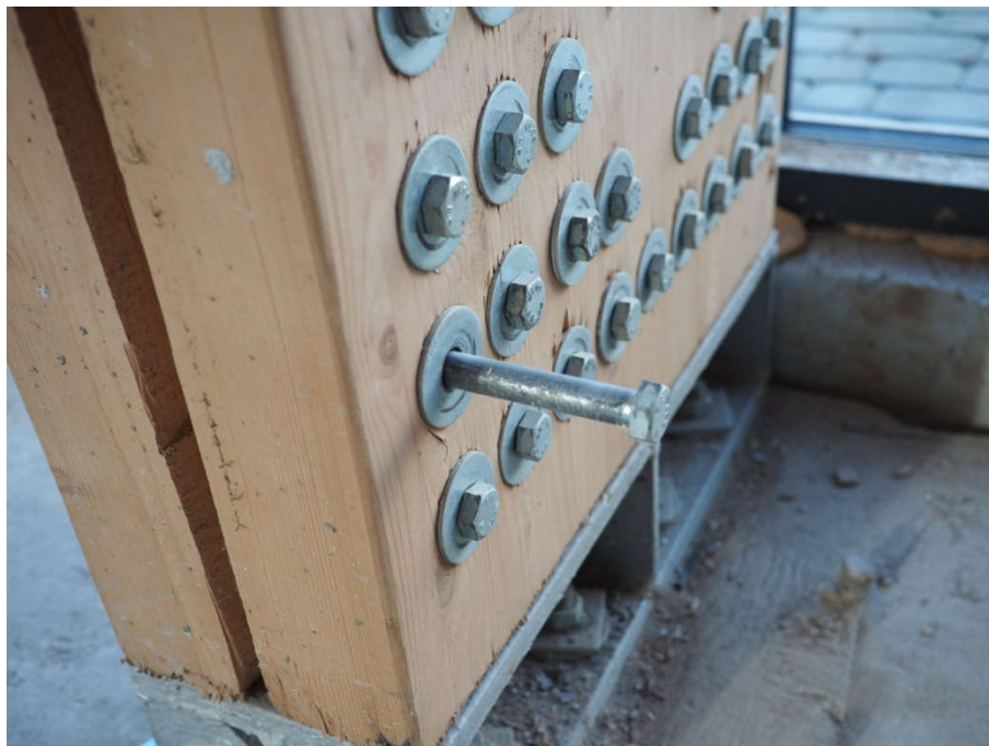
FOT. 23 Sprawdzenie śrub połączenia ramy typu hokej – śruba M16 kl.8.8 gładka w miejscu drewna
