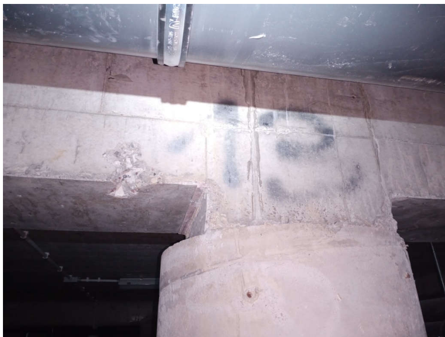
FOT. 16 Odkrywka otuliny belki podbasenia
