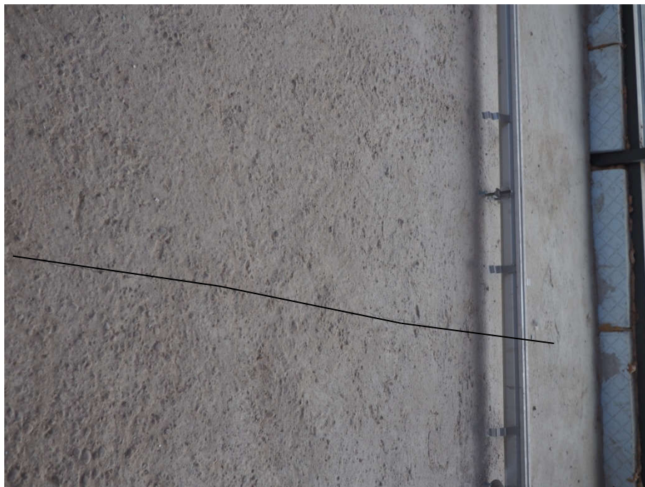
FOT. 13 Pęknięcie płyty podbasenia
