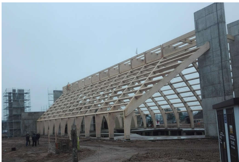
FOT. 22 Zdjęcie archiwalne – widać , że montaż ram rozpoczął od słupów w osi 25
