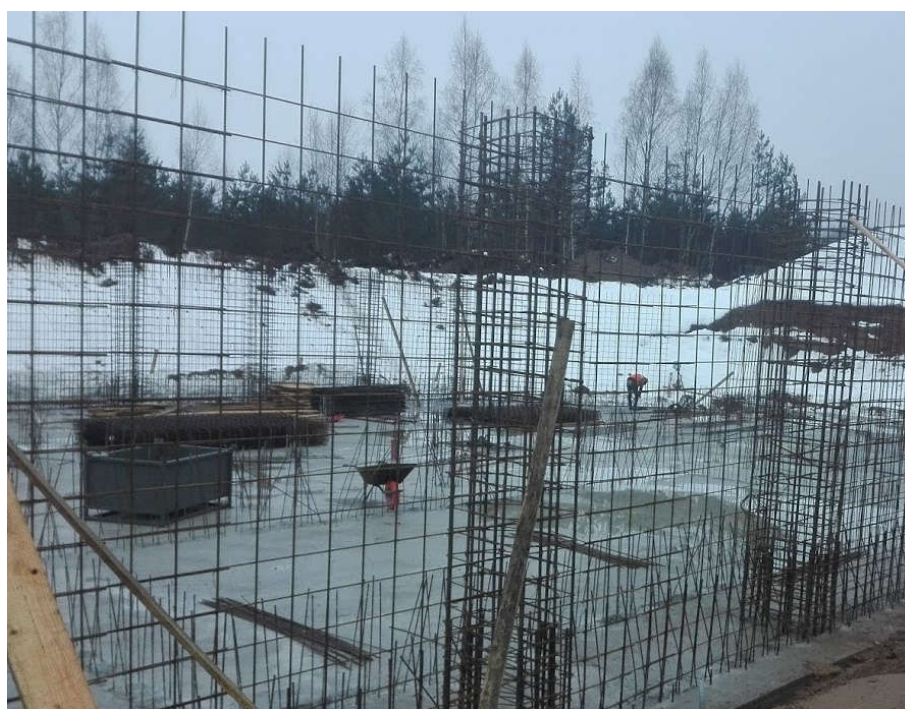
FOT. 9 Zdjęcie archiwalne – widoczne zbrojenie ścian podbasenia – brak rur dylatacyjnych – widoczny zakład prętów w środku rozpiętości ściany
