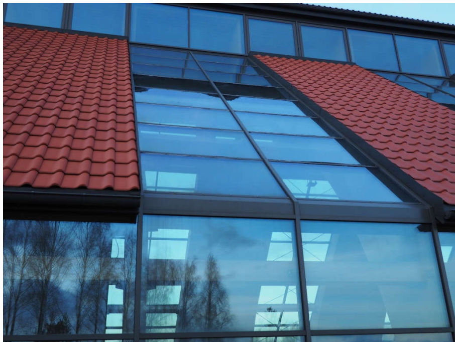
FOT. 31 Widok uszkodzonych maskownic na szybach, całość kwalifikuje się do demontażu
