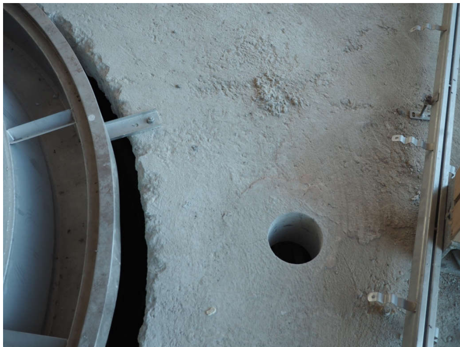
FOT. 11 Widok zarysowanie biegnącego od nawierconego otworu w kierunku wykutego fragmentu stropu pod jacuzzi
