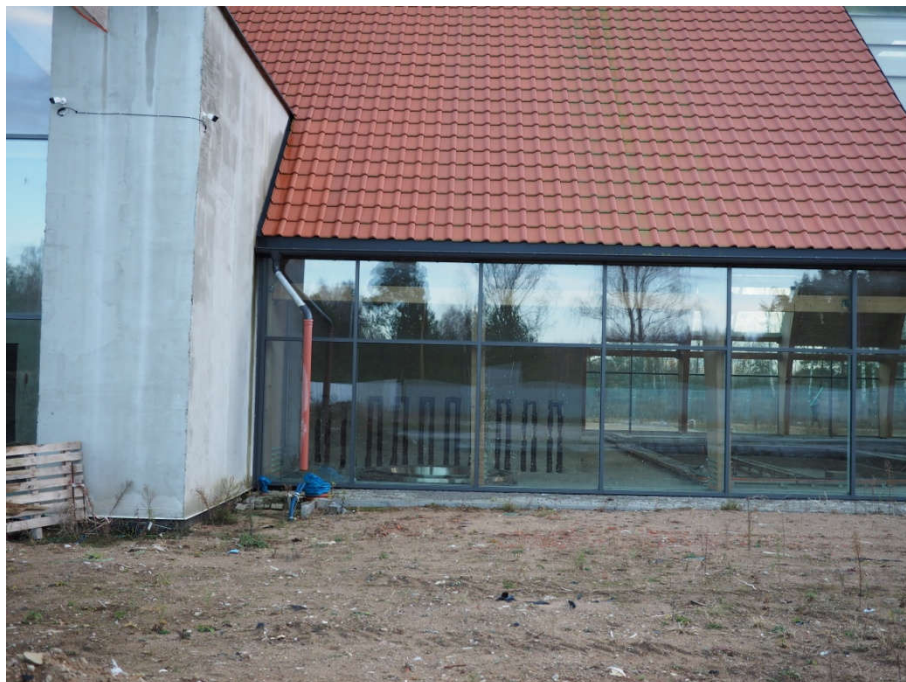
FOT. 21 Widok na stolarkę okienną zamocowaną do krzywych dźwigarów dachowych
