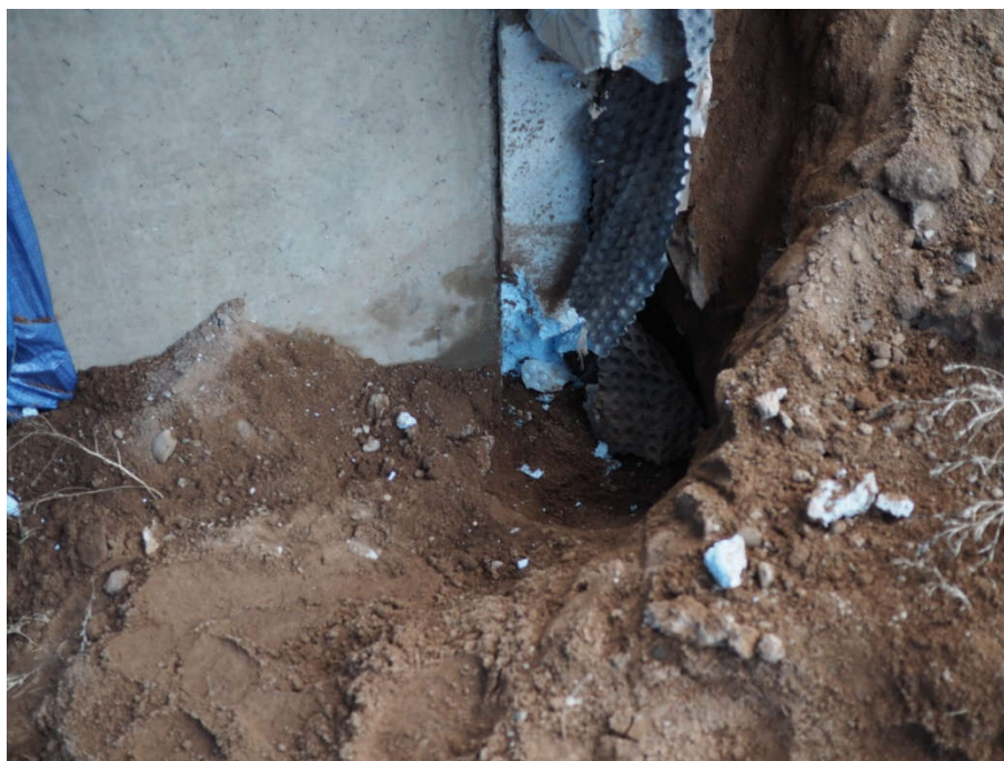
FOT. 1 Odkrywka izolacji pionowej (widoczny styropian i folia kubelkowa, ściana jest pokryta masą bitumiczną)
