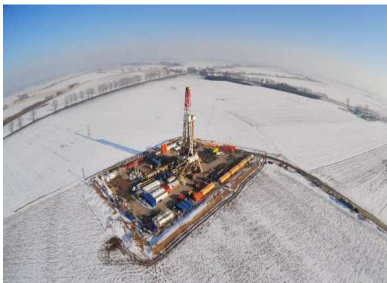
Rys. 6. Wiertnia z zamontowanym urządzeniem wiertniczym typu IRI E-1200 (fot. Exalo)
